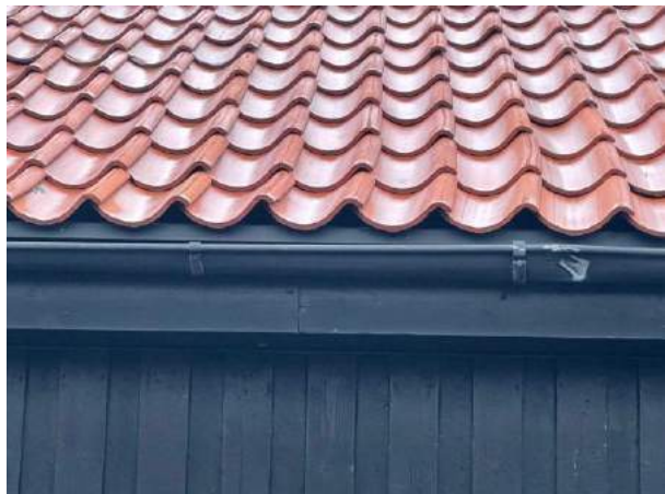
Bild 12: Utvändigt, Yttertak, - Det förekommer många vridna takpannor. Framför allt i nederkant. Har skett efter stormar. Dessa bör återplaceras så det ligger tätt mot ...
