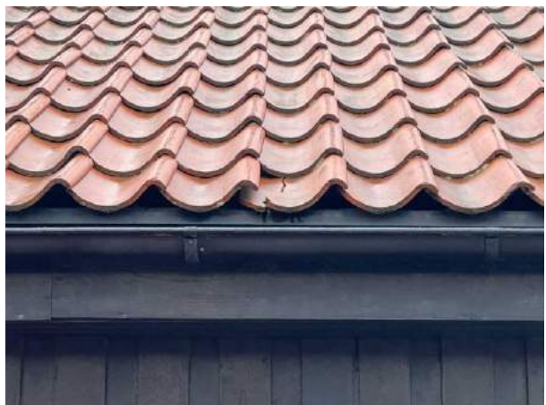
Bild 6: Utvändigt, Yttertak, - Det förekommer spruckna skadade tegelpannor. För att minska risken för fuktrelaterade skador på underlagstaket måste dessa ersättas.
