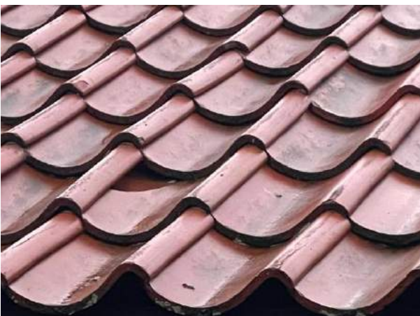
Bild 5: Utvändigt, Yttertak, - Det förekommer spruckna skadade tegelpannor. För att minska risken för fuktrelaterade skador på underlagstaket måste dessa ersättas.
