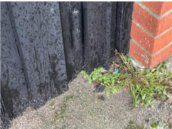
Bild 23: Utvändigt, Fasad, - Mycket träpanel har kontakt med marken vilket innebär risk för förtida fuktskador. Rekommenderar minst 15mm luftspalt mellan panel och...
